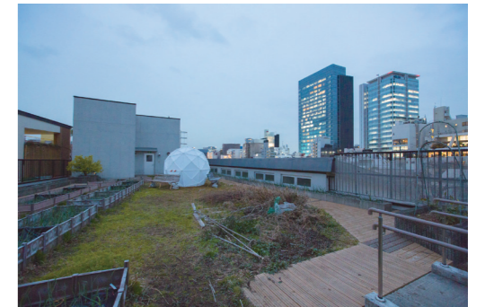
屋上にドーム型の小屋をつくって設置。菜園に活用できるビニールハウスとして作成したが、何に使うかはこれから考えていく。利用者さんや職員さんが疲れた時、一人になりたい時のシェルターのように使ってもらえる場所になるかもしれない。
