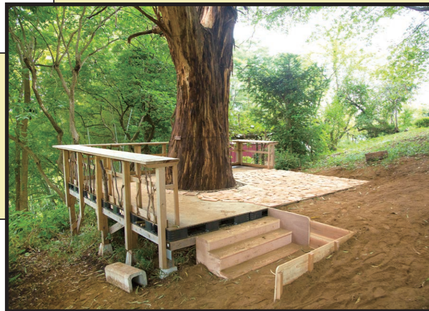
完成したテラスの様子。階段とスロープを設置し、誰もがテラスに上がりやすくなった。
